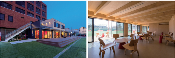
施工例：リバプール・フットボール・センター・川崎 建築設計：山代悟＋ビルディングランドスケープ 撮影：新良太
