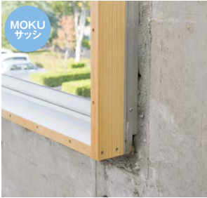
2 既存壁にふかし枠を設置
