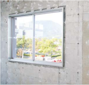
1 既存壁(PB等)の撤去※1
