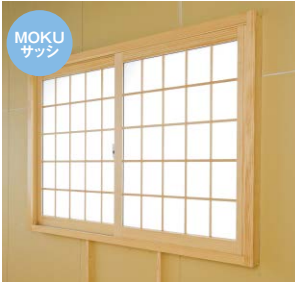
6 MOKUサッシの障子を設置
