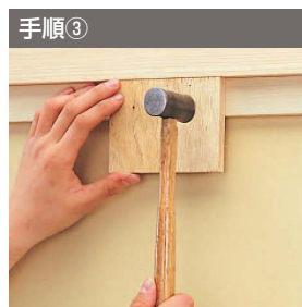
手順③ 化粧材の取付け
