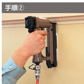
手順② スタイプラーで下地材の本固定
