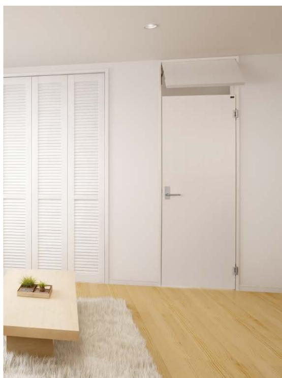
ドアの上部に換気用の欄間を設けて室内の通気性を高めることができます。欄間を閉めると冷暖房による快適な空気が室内から室外へ逃げにくくなるので、状況に応じて心地よい室内で過ごすことができます。
