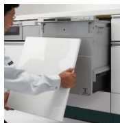
扉を取り付ける
