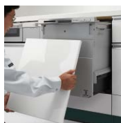
扉を取り付ける
