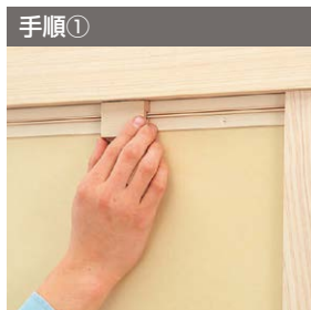
手順① 同梱定規にて下地材の位置決め
