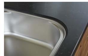
シンクの縁は、人工大理石カウンターを斜めに接合することで汚れを溜まりにくくする「斜めジョイント設計」。
