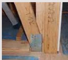
■筋かい耐力壁端部のビス留め
