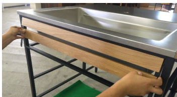
受け金具にスリット板を上側2本取り付けます。
