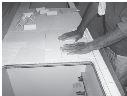
タイルを張りつけている様子
