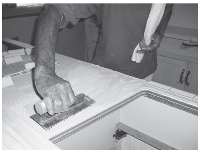
専用接着剤を塗布している様子
