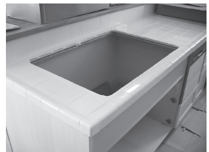
タイルに目地材を充填して乾かします。
