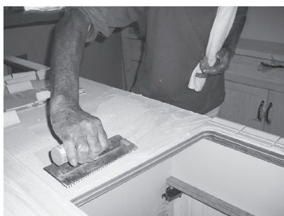
専用接着剤を塗布している様子
