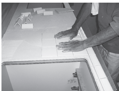
タイルを張りつけている様子
