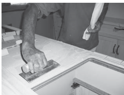
専用接着剤を塗布している様子
