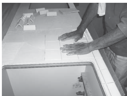
タイルを張りつけている様子
