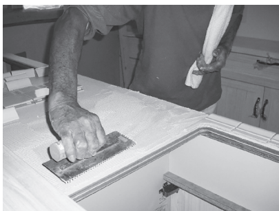
専用接着剤を塗布している様子
