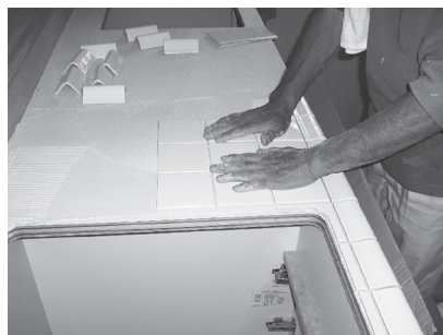
タイルを張りつけている様子
