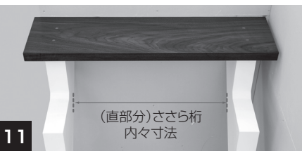
11 踏板を仮置きして、直部分ささら桁の内寸寸法が正しく取れているか確認します。
