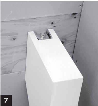
7 取り付け後、ボルトの緩みや金具による軋み音が無いか確認します。
