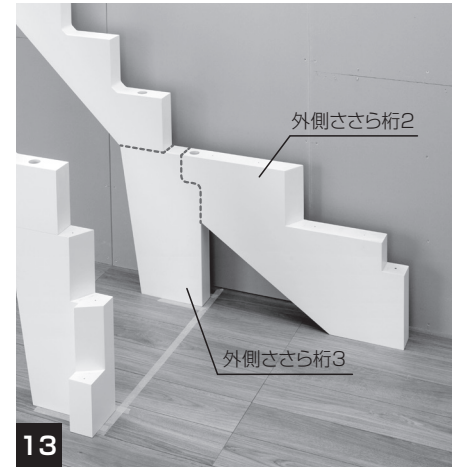
13 「外側ささら桁3」の上に「外側ささら桁2」を仮置きします。
