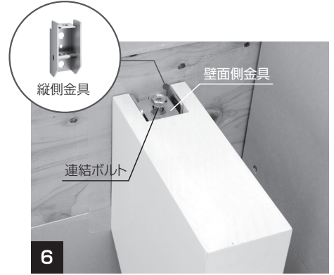
6 「壁面側金具」とささら桁の「縦側金具」を連結ボルトで固定します。ささら桁の「縦側金具」は取付出荷されています。
