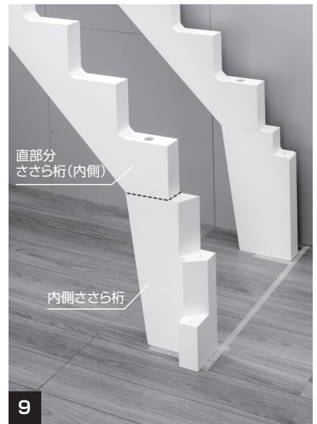
9 同様に、「内側ささら桁」の上に「直部分ささら桁(内側)」を置きます。
