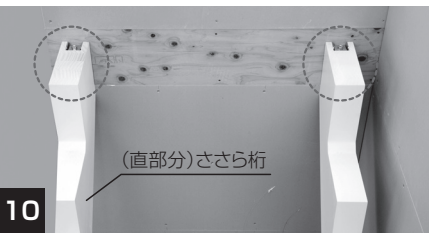
10 同様に、「(上部)ささら桁固定金具」を固定します。
