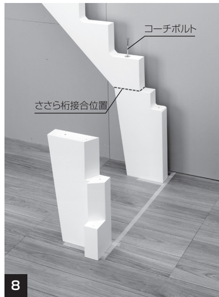
8 「直部分ささら桁」と「外側ささら桁3」の接合位置にズレが無ければコーチボルト(同梱)で固定します。
