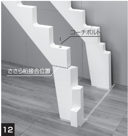
12 同様に、「直部分ささら桁」と「内側ささら桁」の接合位置にズレが無ければコーチボルト(同梱)で固定します。
