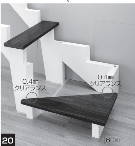
20 廻り踏板1段目をのせませす。「外側ささら桁1」より角の出を60mmにした位置に合わせませす。ささら桁と踏板のクリアランスは0.4mmとってくだささい。 (桁内々650mm、踏板900mmの場合に、角の出60mmになります。直踏板角の出と廻り踏板外周部を揃えてくだささい。)
