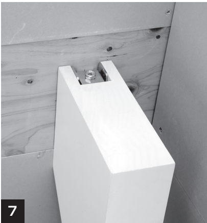
7 取り付け後、ボルトの緩みや金具による軋み音が無いか確認します。
