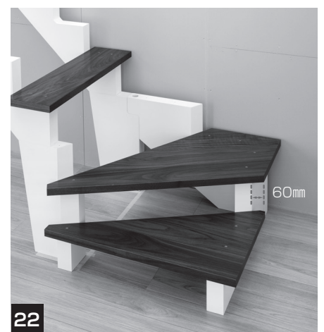
22 同様に3段廻りの2段目を固定します。 (桁内々650mm、踏板900mmの場合に、角の出60mmになります。直踏板角の出と廻り踏板外周部を揃えてくだささい。)
