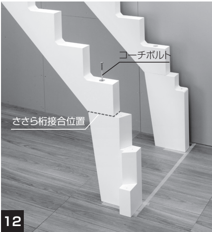
12 同様に、「直部分ささら桁」と「内側ささら桁」の接合位置にズレが無ければコーチボルト(同梱)で固定します。
