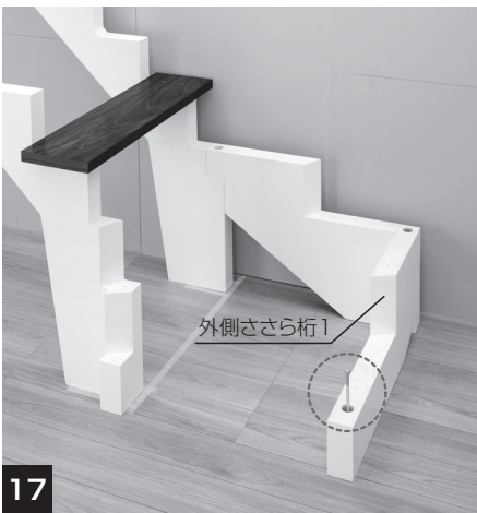
17 内々寸法に問題が無ければ、「外側ささら桁1」をコーチボルトで固定します。
