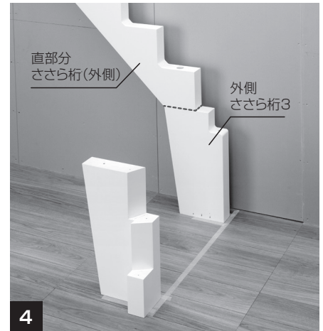
4 「外側ささら桁3」の上に「直部分ささら桁」を置きます。
