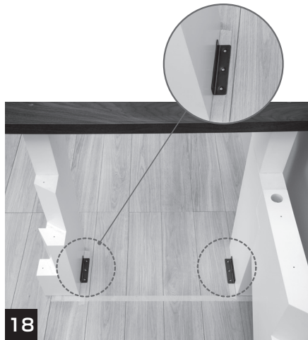
18 「外側ささら桁3」と「内側ささら桁」の内側にL型金具を設置します。 ※判りやすいようにブラックの金具を取り付けています。
