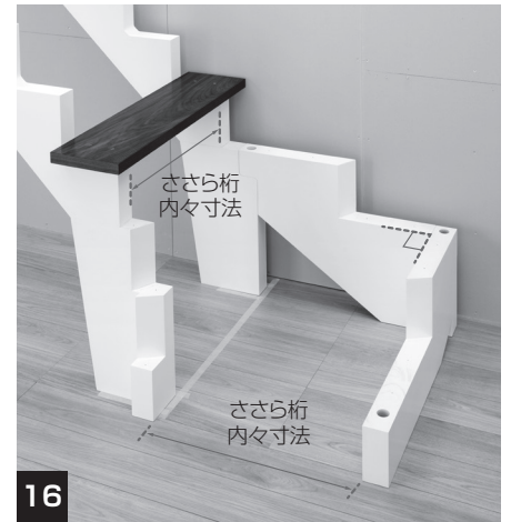
16 直踏板を置いて、直ささら桁の内々寸法が問題無いか確認します。その際ささら桁と壁面の通りも確認してください。また、「内側ささら桁」と「外側ささら桁1」の内々寸法と矩手を確認します。
