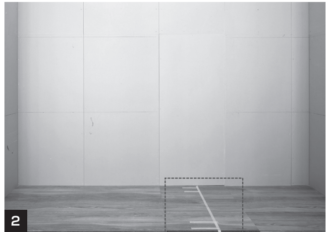
2 基準点からささら桁の位置を墨出します。
