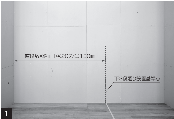
1 下3段廻り設置基準点を墨出します。
