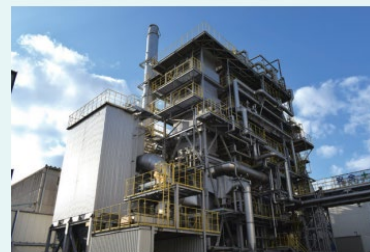
ウッドワン バイオマス発電所
