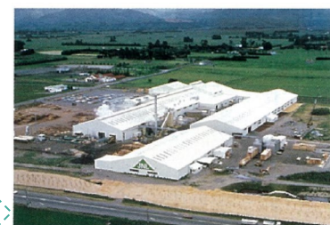
ニュージーランド ワイララバ 工場
