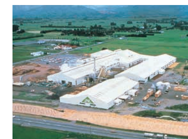
■ニュージーランド ワイララバ工場
