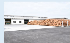
フォレストワン庄原工場（2024年4月11日 竣工）
