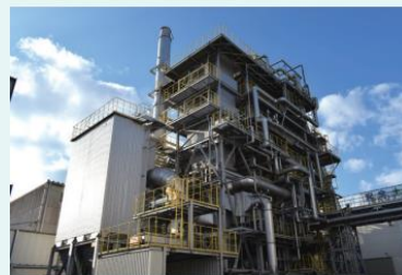
ウッドワン バイオマス発電所
