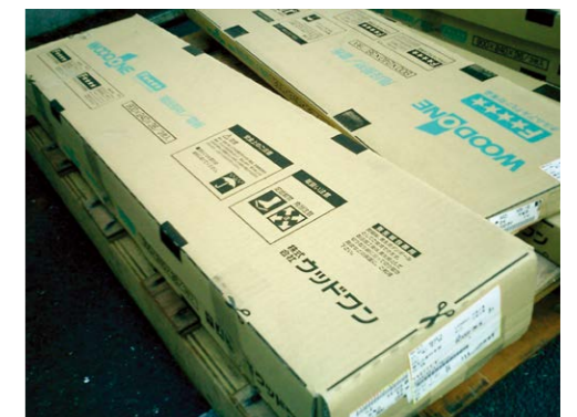
保護材として再利用可能な階段部材のダンボール
