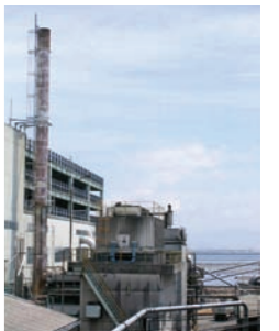
ボイラー(本社)
