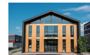
B種 LVL 施工例: ウッドワンプラザ金沢
