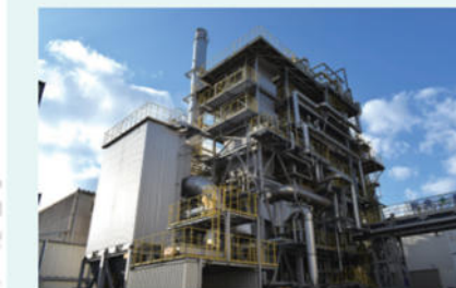
ウッドワン バイオマス発電所
