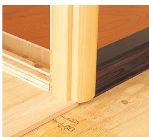
大壁用 敷居との取り付け
