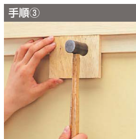
手順③ 化粧材の取付け
