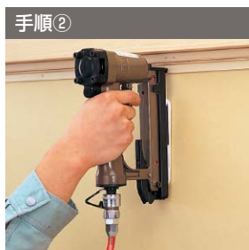
手順② ステップで下地材の本固定
