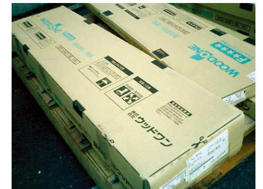
保護材として再利用可能な階段部材のダンボール
