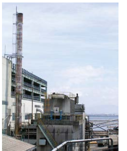
ボイラー(本社)
